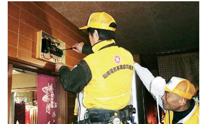
▲ブレーカーの点検をする同組合員たち
