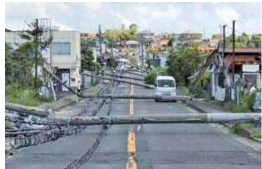
図 2. 倒壊した電柱による道路閉塞 (平成30年台風21号 大阪府泉南市)
