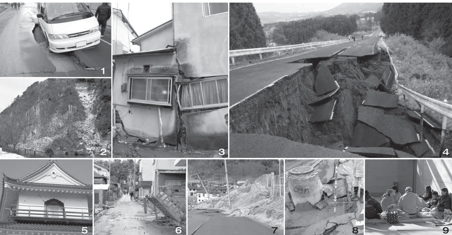
1_道路が陥没した田町地区 2_国指定天然記念物の材木岩も一部が崩落 3_建物にも大きな被害が 4_道路が崩れた国道457号 5_漆喰壁が一部崩れた白石城 6_ブロック塀が崩れ落ちるなど被害が大きい南町地区 7_東中学校校庭法面が崩落。一部の地域に避難勧告が出された 8_隆起したマンホールが至る所に 9_避難所での生活
