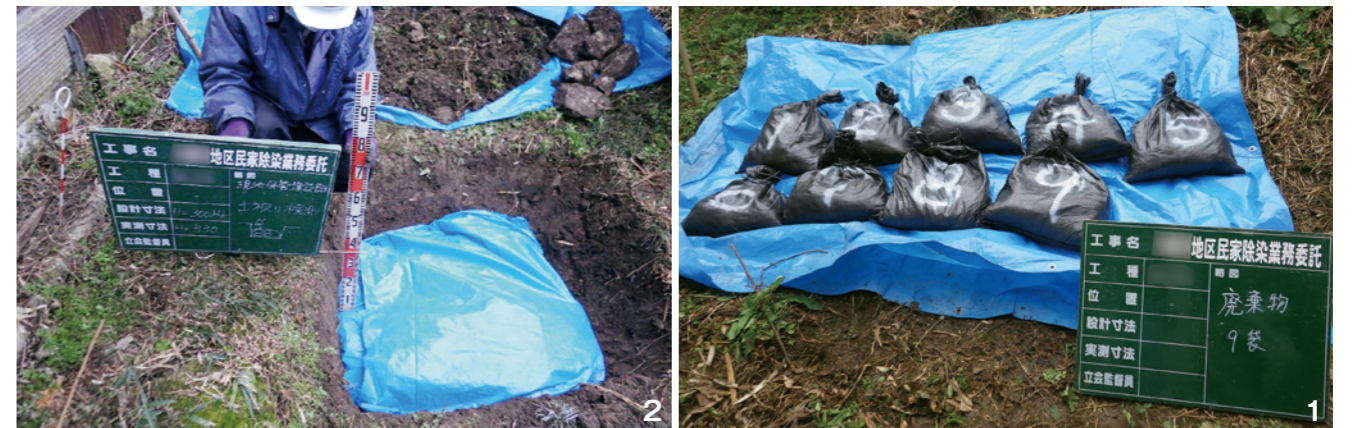
1_除染廃棄物(除去土壌など)の保管前の状況。耐候性の土のう袋に除染廃棄物を入れます 2_ブルーシートで養生して必要な盛土厚を確認し、地下保管します。この保管に際しては、現場で空間放射線量を測定。覆土厚や保管量、空間放射線量を記録した台帳を市で保存します。除染の方法などによって、この除染廃棄物が発生しない場合もあります
